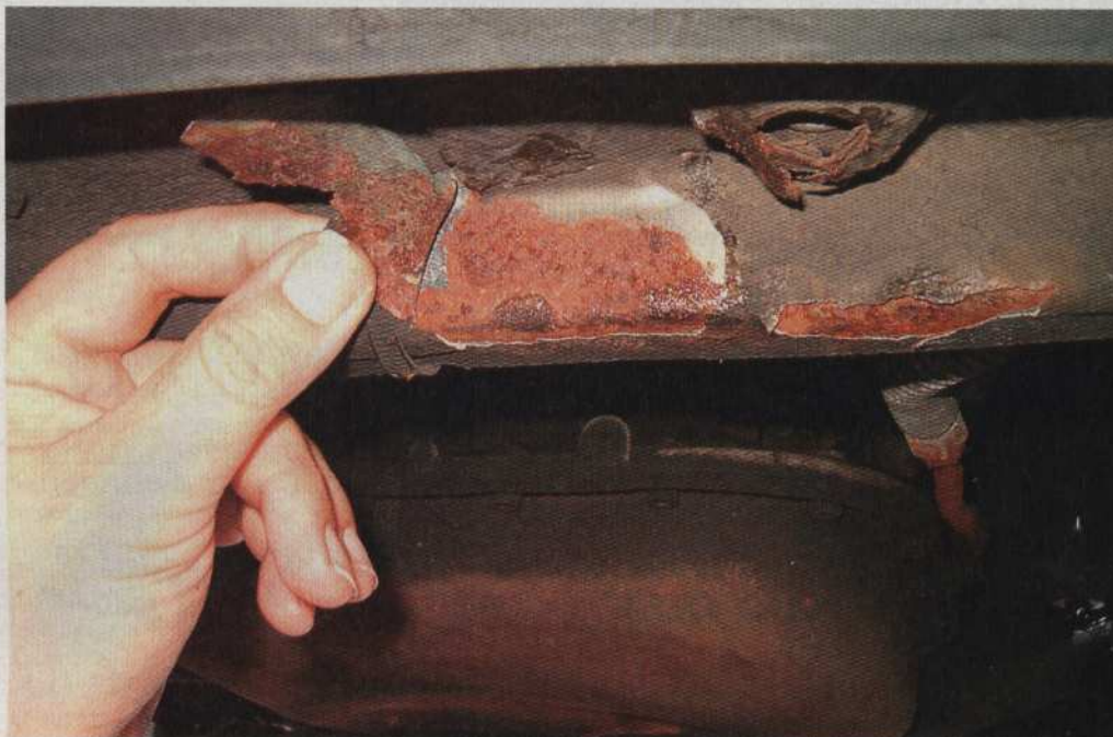
Oft lauert das nackte Grauen unter äußerlich gutem Unterbodenschutz – durch mechanische Beschädigungen wurde er unterwandert
